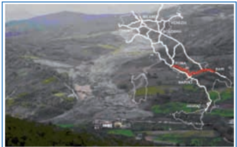
Figura 7.16: Frana di Montaguto (A V) 18
