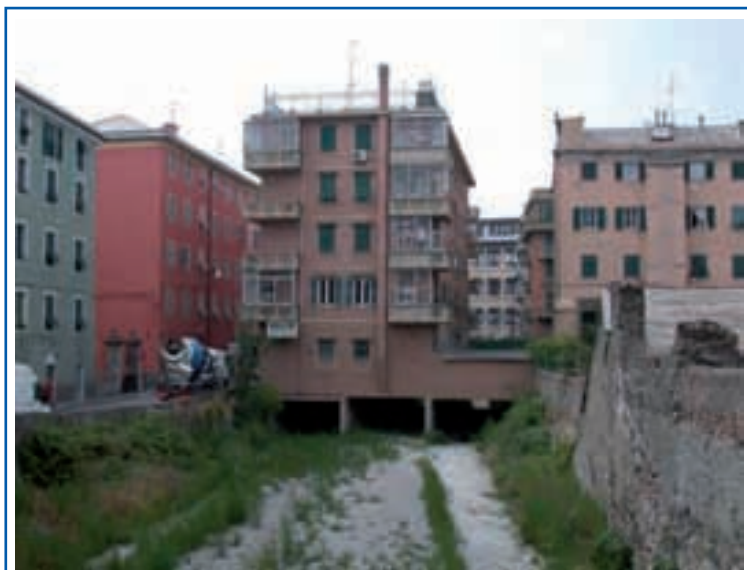
Figura 7.18: Palazzina edificata sull'alveo del torrente Chiaravagna a Genova 20
