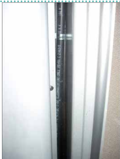
Figura 3: Vista del vano di alloggiamento apparati su ETR 600
